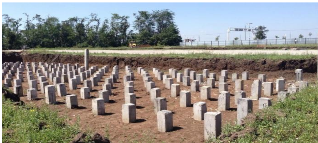
Рисунок 11. Забивной фундамент
