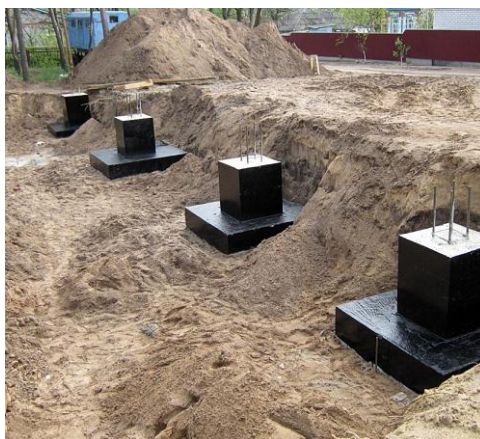
Рисунок 6. Фундамент стаканного типа
